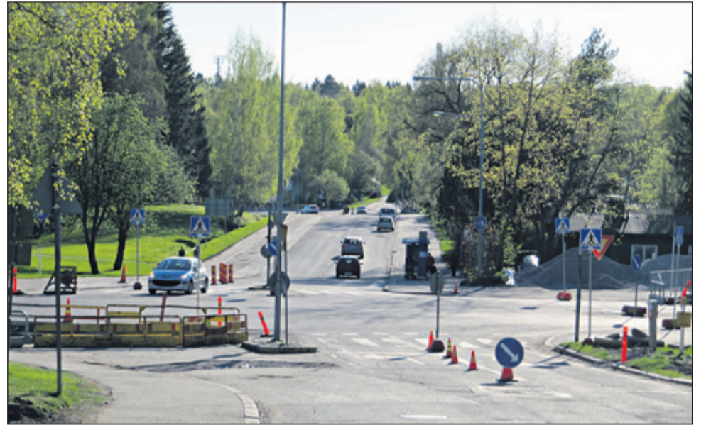
Pakilantien - Pirjontien kiertoliittymän rakentaminen on alkanut ja kiertoliittymä valmistuu loka-marraskuun vaihteessa 2013.
