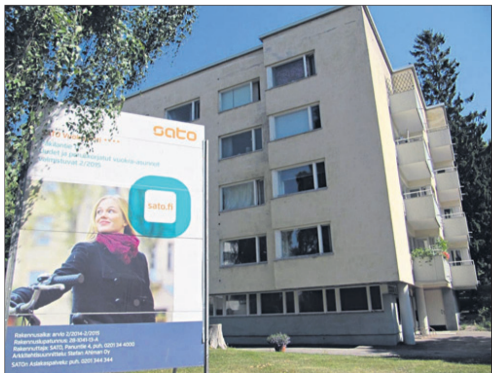
Sato tekee peruskorjauksen Pakilantie 17 kerrostalossa ja rakentaa viereen lisärakennuksen. Rakentaminen alkaa helmikuussa 2014 ja uusi rakennus valmistuu helmikuussa 2015.
