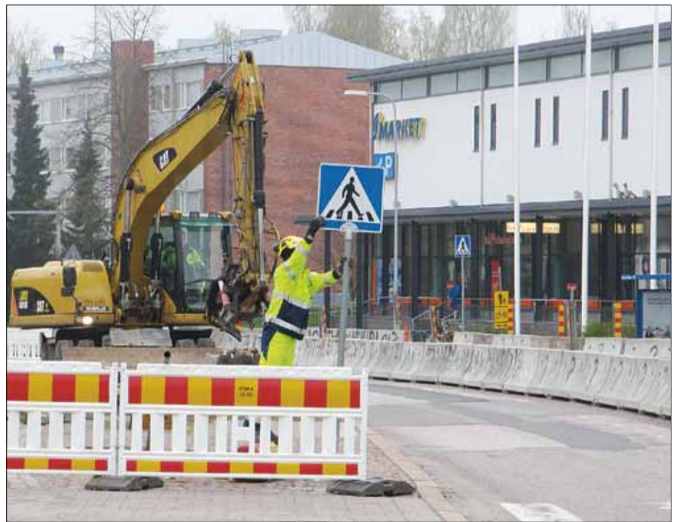
Ostoskeskuksen purkamisen käynnistyminen mahdollisti Pakilantien muutoksen loppuun saattamisen
