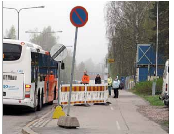
Suursuon ostoskeskuksen bussipysäkki siirtyi katutöiden ajaksi Pakilantie 15:n kohdalle
